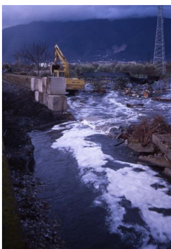
Figura 9a: Esondazione del 1995 del Torrente dei Corvi a Nocera Superiore, vista dal punto di cedimento dell'argine.
