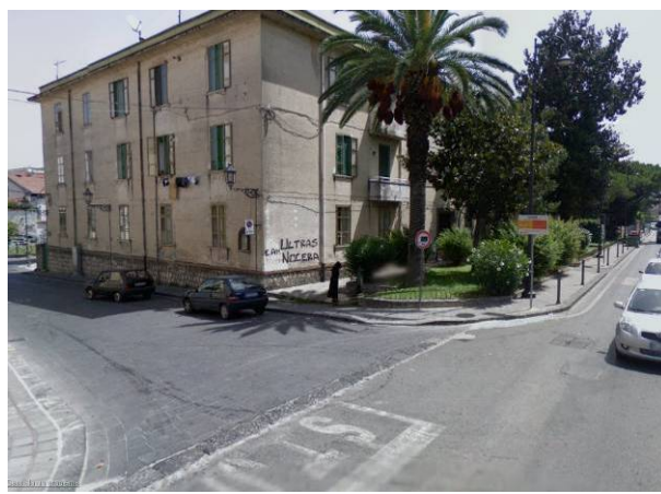
Mancanza di segnaletica d'indirizzamento alle aree di sosta (Parcheggio via Sarajevo)
