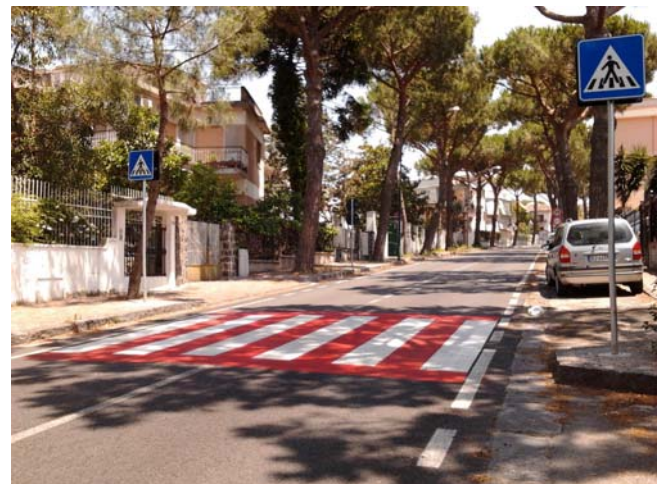
Attraversamento pedonale a livello con pavimentazione stradale colorata
