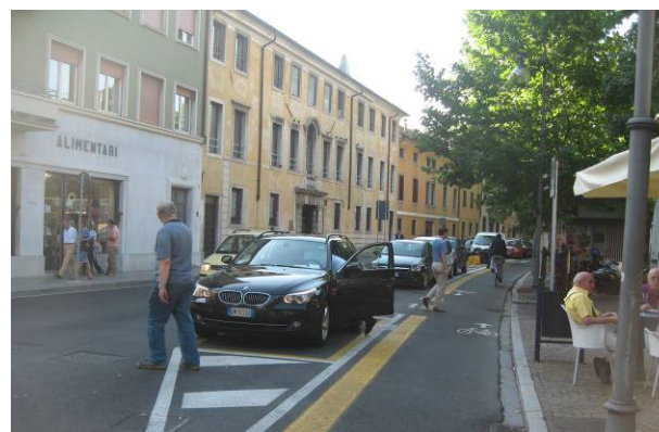
Esempio di pista ciclabile su sede stradale delimitata da stalli di sosta
