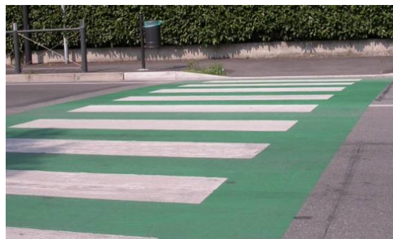
Attraversamento pedonale a livello con pavimentazione stradale colorata
