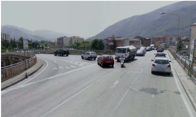
Intersezione tra il cavalcavia Mancuso e via De. Nicola, accesso all'area dell'Ospedale
