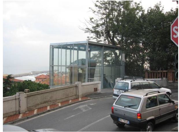
Stazione di monte dell'ascensore inclinato di Imperia
