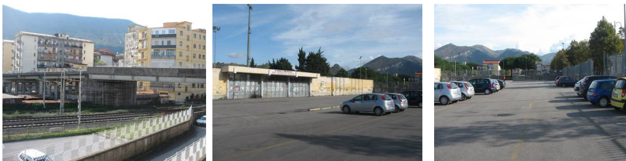
Il cavalcavia di accesso all'ospedale e allo stadio
